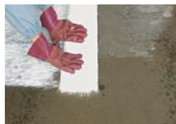
ガラスマット#450敷設
