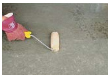
ポリキュートPC-640FXT塗布 (下塗工程)
