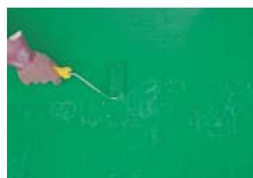
防水トップコートPC-855TP塗布 (上塗工程)
